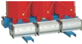
Трансформатор с системой принудительного охлаждения.
